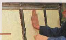
横にされて隙間なく積み上げられ、軸の壁を作る。はみ出た軸は取り除かれる。
